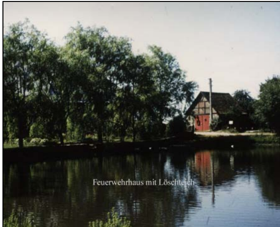
Feuerwehrhaus mit Löschteich
