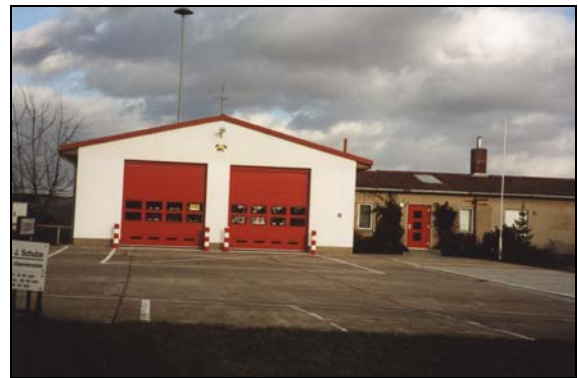
Neues Feuerwehrgebäude nach dem Umbau
